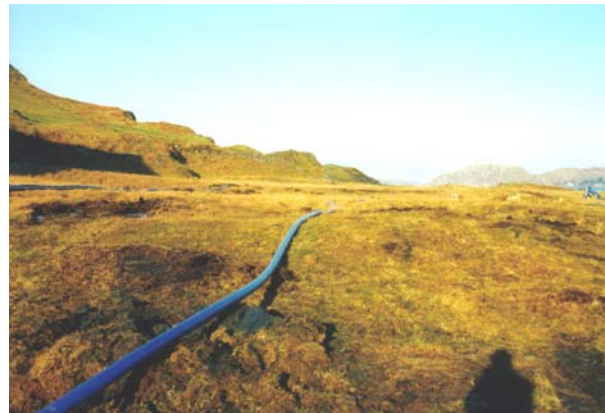
124 mm PE Pipe Across Moorland
